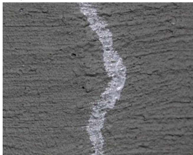
Fot. 5. Pomalý růst krystalů soli na povrchu trhlin, finální utěsnění. Účinek po 35 dnech.
