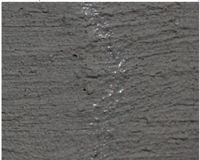
Fot. 3. Postupné uzavírání trhliny krystalizujícími solemi, stále dochází k mírnému úniku vody. Účinek po 7 dnech.
