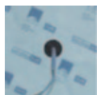
Těsnící manžeta pro vodotěsné a větrotěsné napojení prostupů přes poj. hydroizolace, viz str. 35
