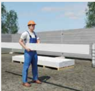
Fasádní desky HardiePlank® noste vždy na výšku
