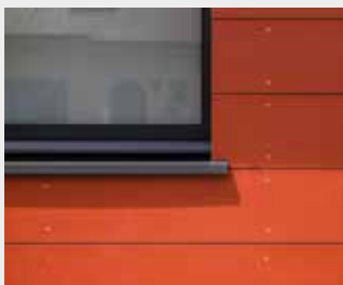
Horizontální pokládká s otevřenými spárami
