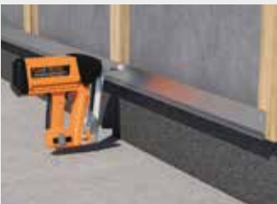
Upevnění soklového ventilačního profilu.
