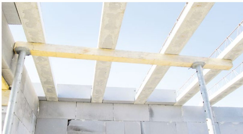
Podpěření stropních nosníků
