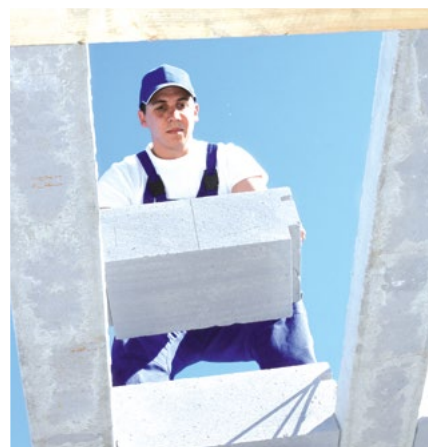
Ukládání stropních vložek
