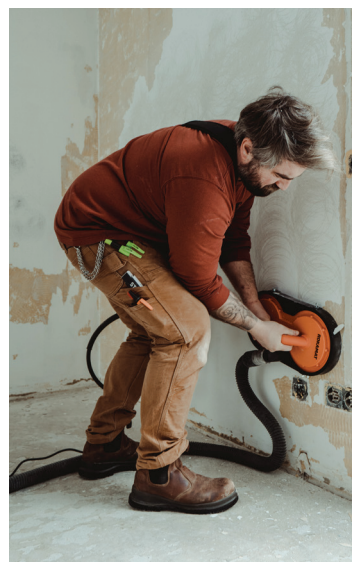
Odstranění starého nátěru
