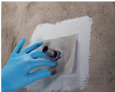
Instalace manžety Mapeband PE 120 na utěsnění prostupu potrubí s použitím Mapegumu WPS
