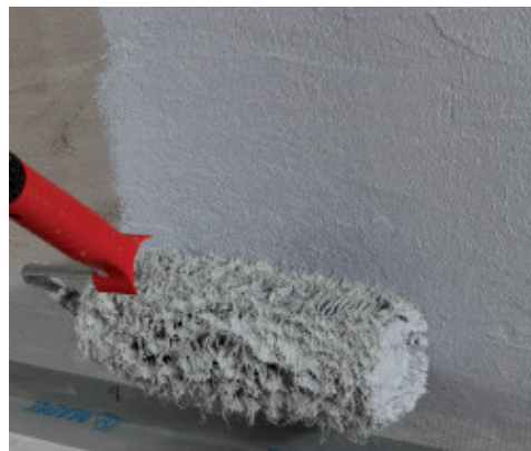
Aplikace hydroizolační stěrky Mapegum WPS válečkem
