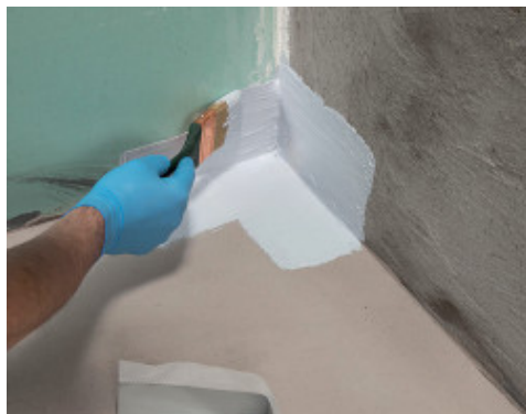
Instalace rohové tvarovky 90° Mapebandu PE 120 lepené výrobkem Mapegum WPS
