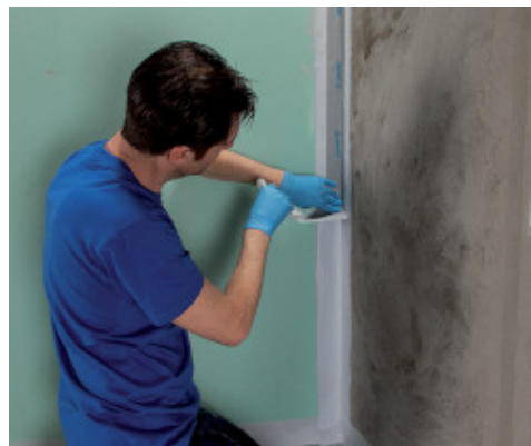
Instalace pásu Mapeband PE 120 lepeného výrobkem Mapegum WPS
