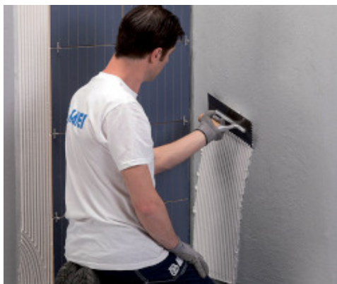
Lepení obkladu s použitím lepidla Keraflex Maxi S1
