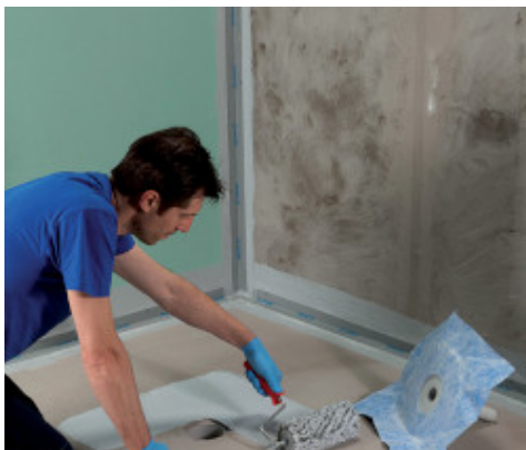
Instalace tvarovky Drain Vertical s použitím Mapegumu WPS
