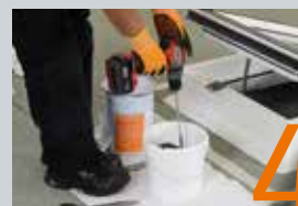
Rozmíchat tekutou hydroizolaci
