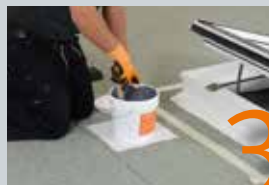
Rozmíchat tekutou hydroizolaci
