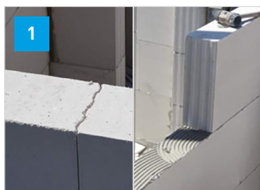
Detail ložné a styčné spáry
