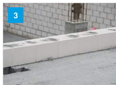
Detail založení zdiva pomocí tvárnice Silka E240 výšky 199 mm.
