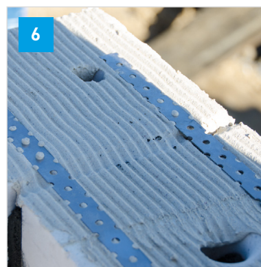
Spojování nosných stěn spojkami zdiva
