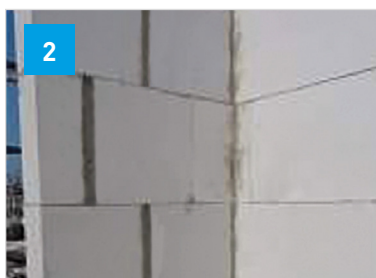
Detail styčné spáry vyplněné maltou
