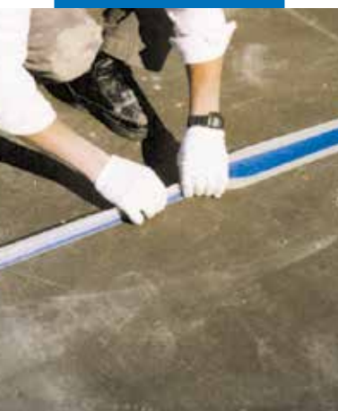
Ukázka hydroizolace dilatační spáry na terase
