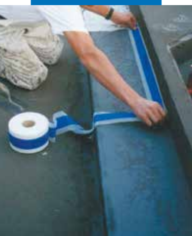
Ukázka hydroizolace přechodu mezi dnem a stěnou vany pásem Mapeband
