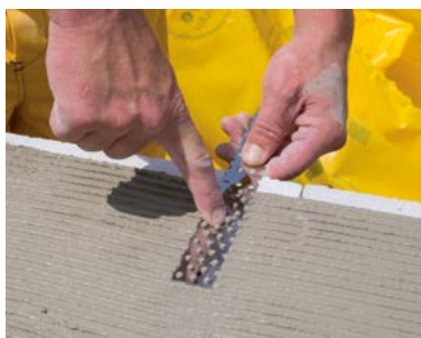
Průběžné vkládání spojky zdiva do ložné spáry
