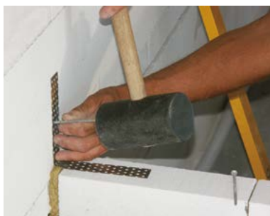
Dodatečná montáž spojky zdiva
