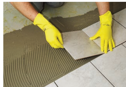
Plochy lepené pomocí PCI FT ® Rapid jsou velmi rychle pochozí a připraveny ke spárování.
