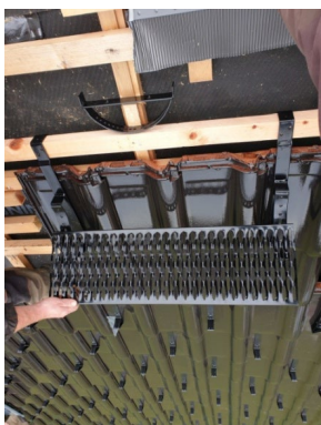
Nastavení vzdálenosti držáků
