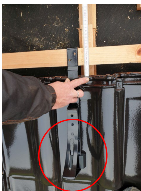
Umístění držáku do spodní vlny
