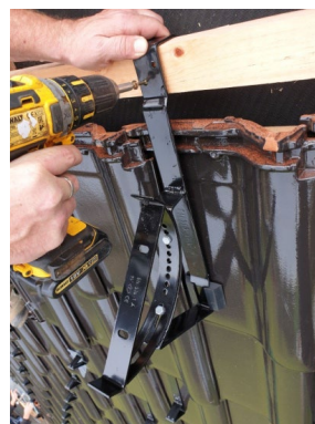
Přišroubování držáků k přídatné lati
