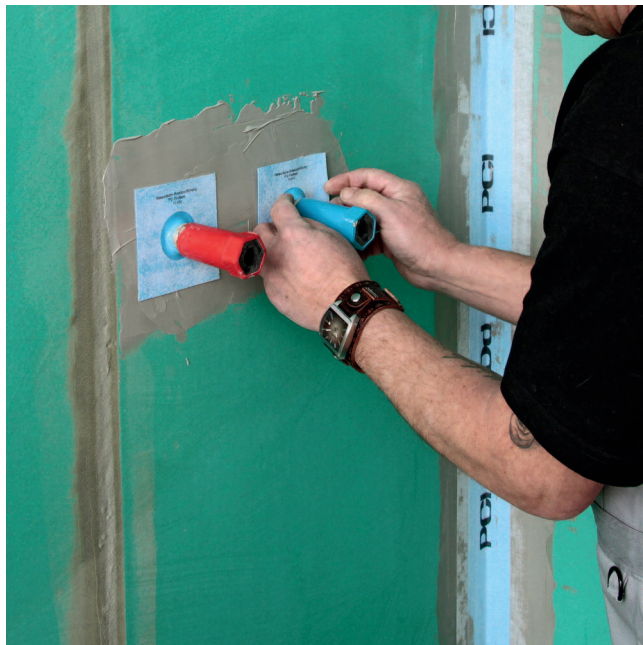
2. PCI Pecitape® 10 x 10 nasadit přes připojení potrubí vyčnívající ze zdi a zaizolovat pomocí PCI Lastogum® (šedý).
