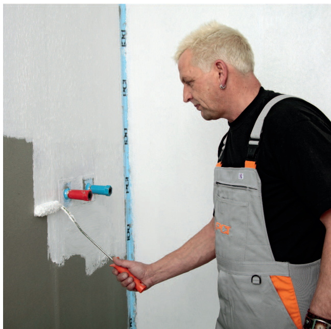
5. Druhá vrstva izolace PCI Lastogum® (bílá, zvolena druhá barva, aby bylo zřetelně vidět překrytí jednotlivých od sebe barevně se lišících vrstev) se nanese po cca 1 hodině odvětrání. První vrstva nesmí prosvítat, v případě potřeby se opakovaně přetře.
