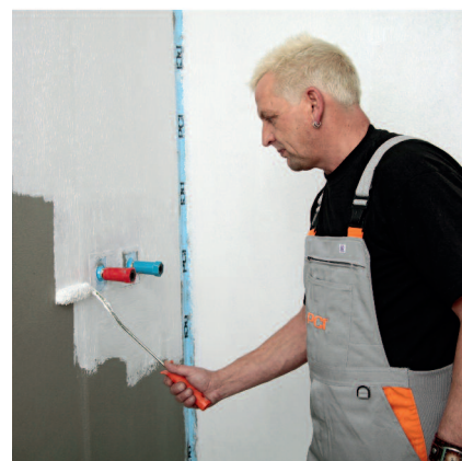
Nezředěná izolace PCI Lastogum® se nanáší na podklad válečkem, štětkou nebo hladítkem.
