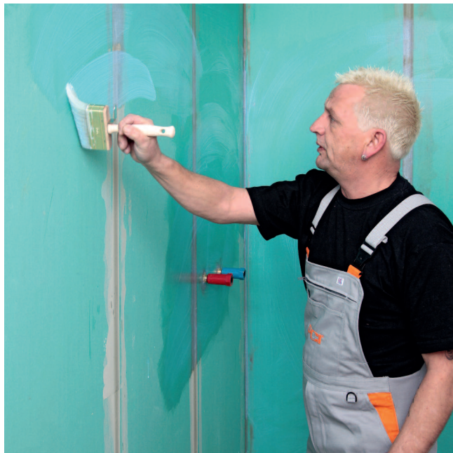
1. Penetrace: savé minerální nebo sádrové podklady a sádkartonové desky natřít penetrací PCI Gisogrund®.
