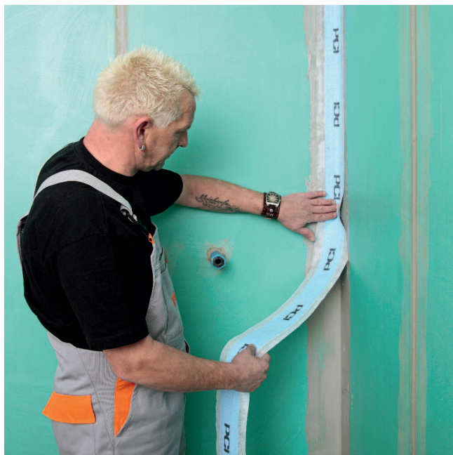
3. K utěsnění rohových spár a u spoje stěna podlaha se použije jedna z těsnících pásek PCI Pecitape® - v tomto případě se jedná o PCI Pecitape® 120 - přetřený izolací PCI Lastogum® (šedý).
