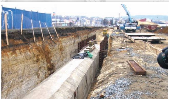
Izolace zemní tělesa Kanal Václava Klimenta v Mladé Boleslavi, 10000 m 2 GD: Bostas a.s., 2000
