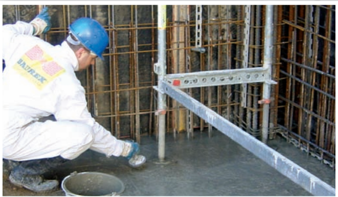
Izolace základové desky Polyfunkční dům v Lipové v Liberci, 600 m 2 GD: Metrostav a.s., 2005
