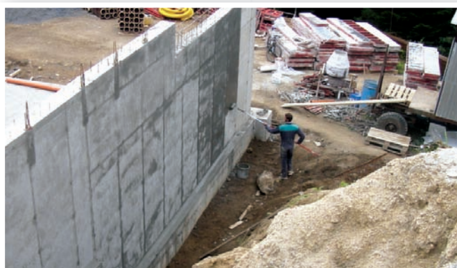
Izolace spodní stavby RD Firmy Soare s.r.o. v Jablonci nad Nisou, 2100 m 2 Dodavatel: Havax a.s. Liberec, 2002
