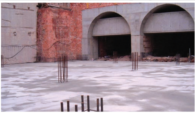
Izolace základové desky
