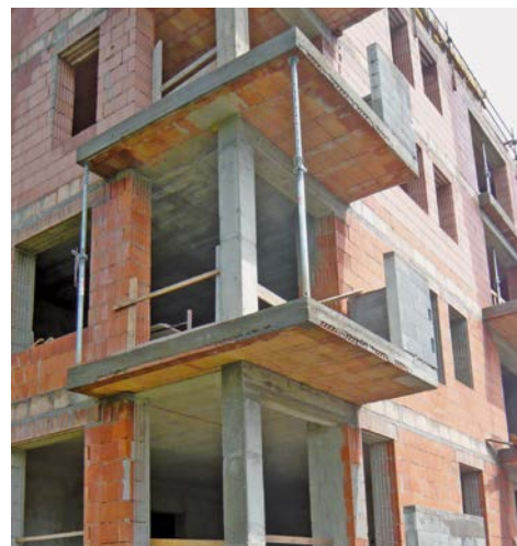
Rohový balkón s přidanou výztuží
