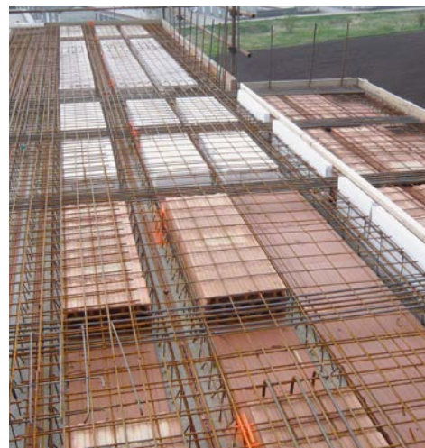
Přerušení tepelného mostu mezi balkónem a stropem
