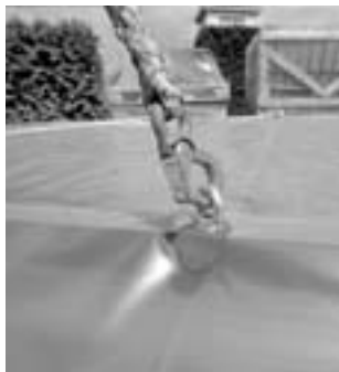
Zavěsit zvedací lano – hák na kolektor
