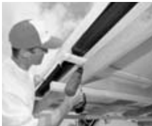
Odmontovat dřevěnou konstrukci z kolektoru
