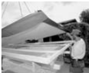
Sejmout dřevěnou konstrukci z kolektoru
