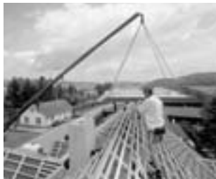
Vyzvednutí kolektoru na střechu ve vodorovné poloze
