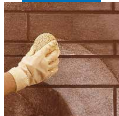
Čištění a konečná úprava spár houbou
