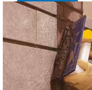
Nanášení Ultracoloru Plus gumovou stěrkou na stěnu
