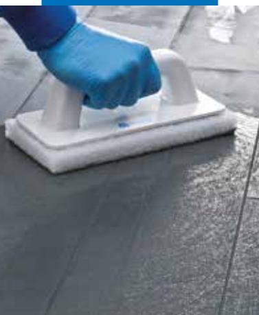
Čištění a konečná úprava spár s použitím Scotch-Brite®
