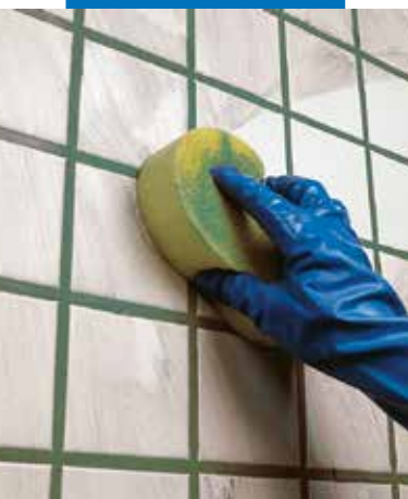
Čištění a konečná úprava obkladů houbou
